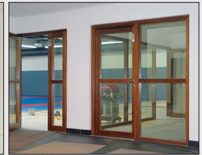
Châssis vitré PF 1/2h en bois peint. Bloc porte CF 1/2h à 2 vantaux vitrés avec cadre bois vernis. 1/2h Fire-Rated painted glazed wooden frame. 1/2h Fire-Rated doorset with 2 glazed leaves with varnished wooden frame.
