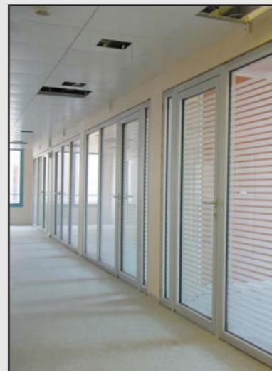
Cloison vitrée CF 1h en aluminium anodisé avec vitrophanie. Cloison vitrée CF 1h en acier thermolaqué. 1h Fire-Rated anodized aluminium partition with decorative films. 1h Fire-Rated partition with painted steel profiles.
