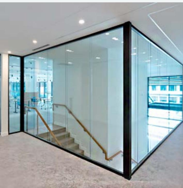
La ID2 peut être utilisée comme cloison faisant office de garde-corps **(sous réserve de validation par le bureau de contrôle).**
