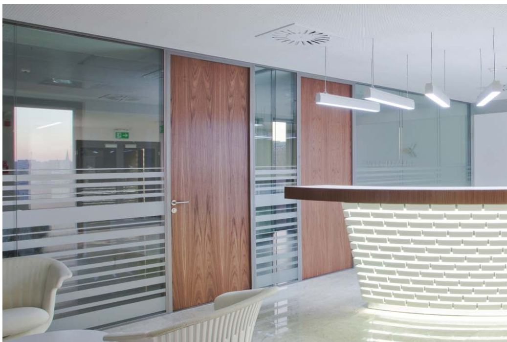
Cloison ID2 en aluminium laqué, double vitrage bord à bord, portes bois toute hauteur
